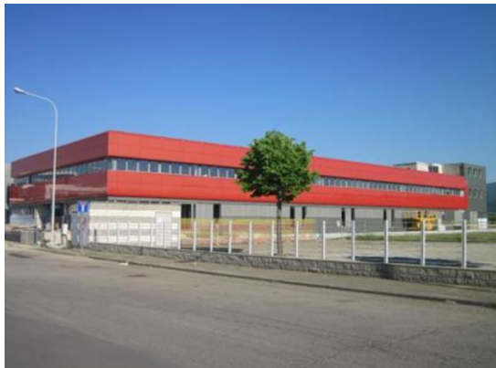
Figura 5: Immagine esterna del Datacenter
