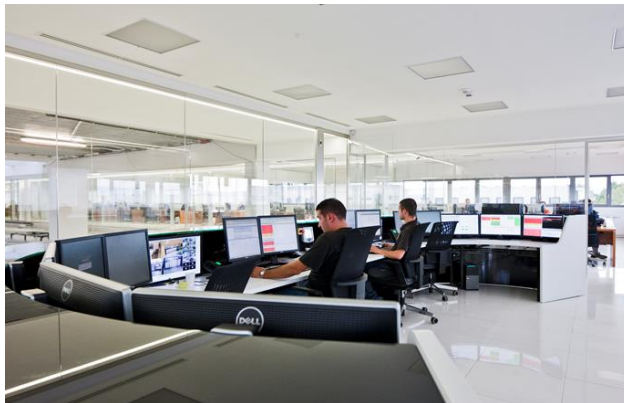
Figura 6: Immagine del Network Operations Center
